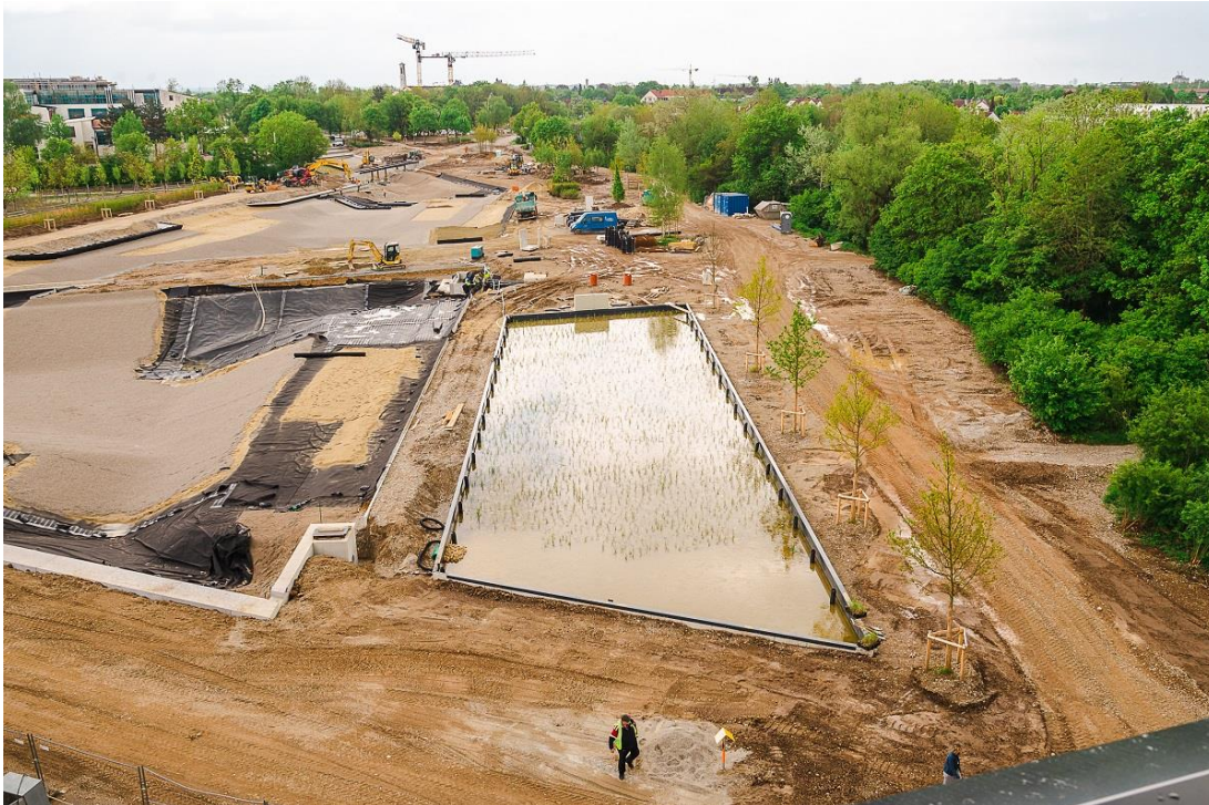
Links im Bild: Die Nordhälfte des neuen Parksees (noch ohne Wasser), rechts im Bild: das Retentionsbodenfilterbecken Nord fast vollständig bepflanzt. Foto: FJSmedia/Franz-Josef Seidl
